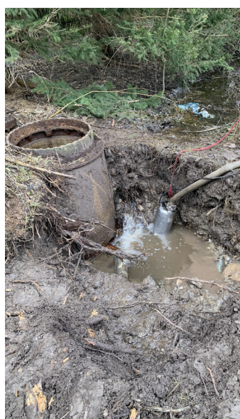
Dne 6. 2. 2024 naše středisko odstranilo havárii na vodovodním řádu na Vilémovské ulici u č. p. 424. Opravou jsme snížili únik vody přibližně o 0,40 l/s.
