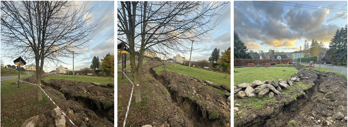
Výkopové práce OMEXON – - Firma OMEXON pokládá nadzemní elektrické vedení společnosti ČEZ do země a zároveň ruší sloupy, po kterých bylo vedení taženo. Jako město jsme využili této příležitosti a totožným výkopem vedeme naše veřejné osvětlení. Díky této spolupráci ušetříme velké množství finančních prostředků, které bychom jinak museli vynaložit z důvodu zachování veřejného osvětlení. Jakmile bude tato fáze dokončena, ulice Mikulášovická se může těšit na nové sloupy VO, jelikož ty stávající mají již nevyhovující stav.
