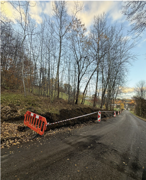
Výkopové práce OMEXON
