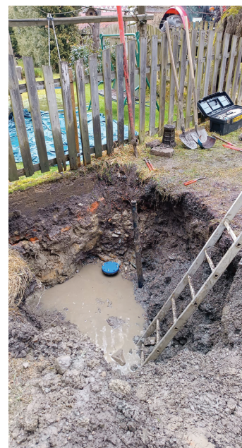
◀ Oprava kanalizační šachty
