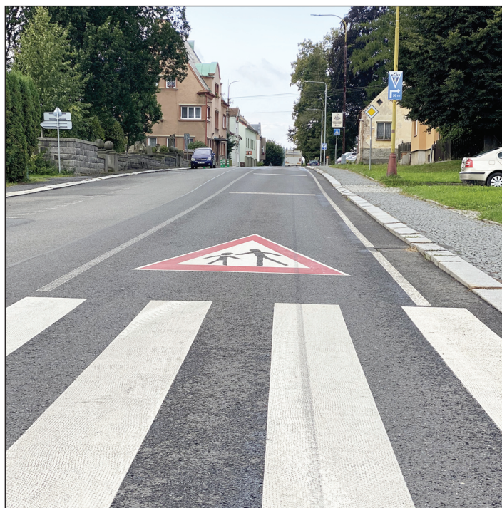
Instalace bezpečnostních prvků před budovou I. stupně ZŠ
