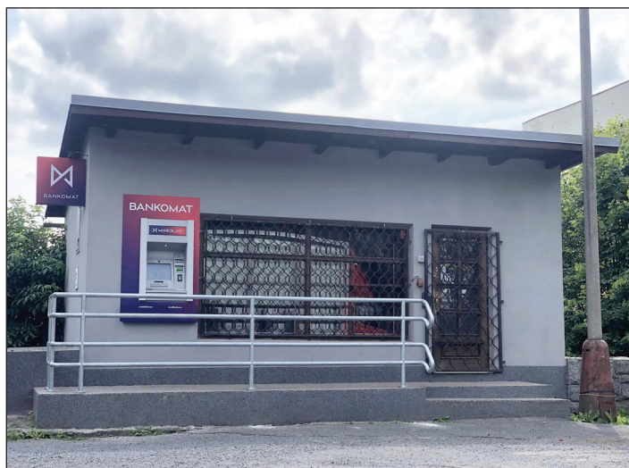
Instalace bezpečnostního zábradlí ke kiosku na náměstí a k bistro.
