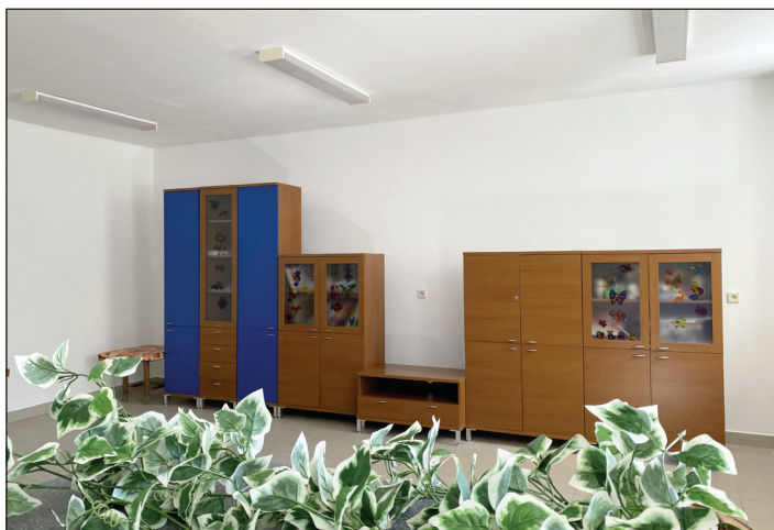
Sanační zednické práce v budově II. stupně ZŠ
