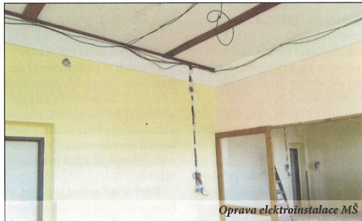
Oprava elektroinstalace MŠ
