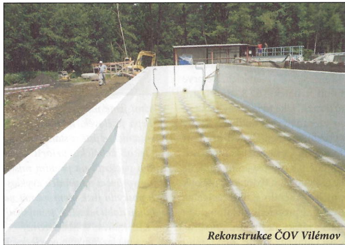
Rekonstrukce ČOV Vilémov
