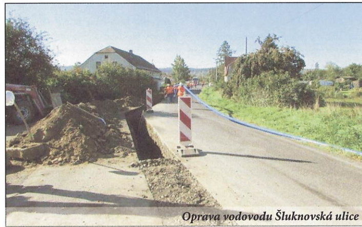
Oprava vodovodu Šluknovská ulice
