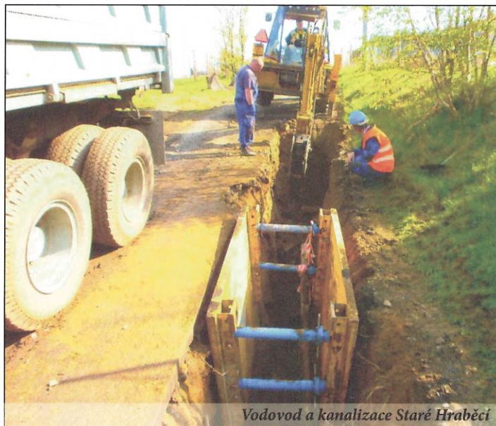
Vodovod a kanalizace Staré Hrabčíc
