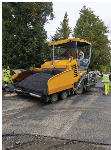
Oprava místních komunikací po realizaci kanalizace a vodovodu
