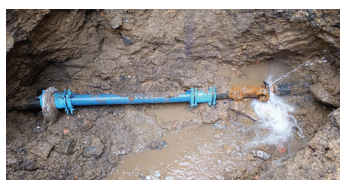
Oprava vodovodního řádu
