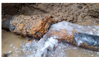
Oprava vodovodního řádu
