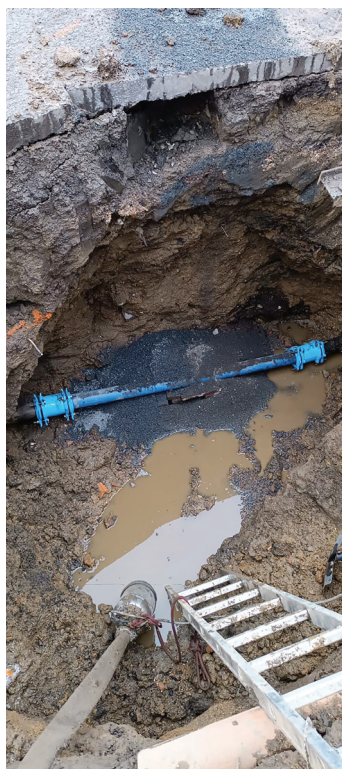
Oprava vodovodního řádu
