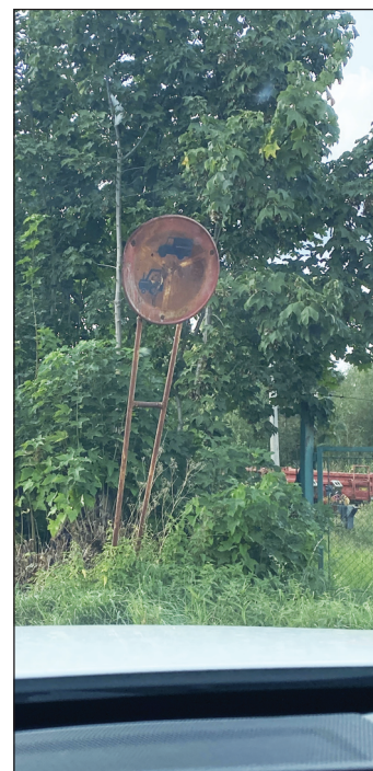
Prováděli jsme místní šetření ohledně dopravního značení, které je poškozené nebo vlivem stáří již neodpovídá potřebnému stavu. Na základě toho šetření proběhla objednávka a následná montáž nového dopravního značení.
