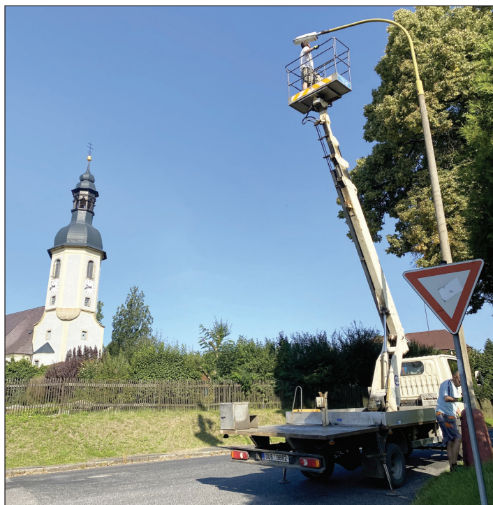
Realizování výměny veřejného osvětlení za nové.
